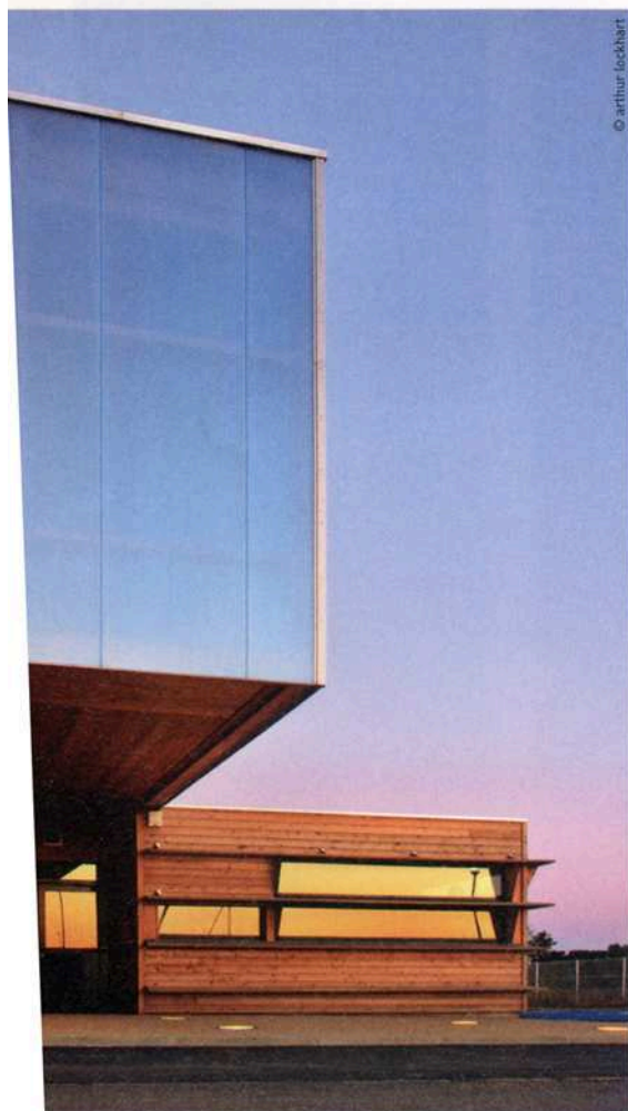
Gymnase à Lansargues (34). Architectes : Architecture Environnement P.M.
