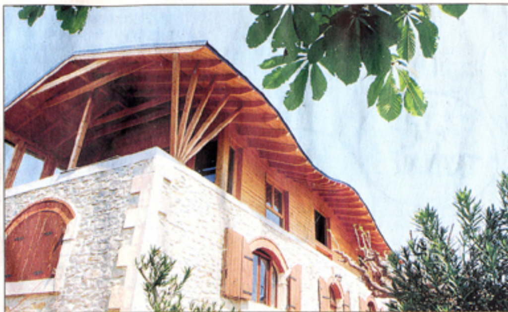
Le vieux lavoir de Beauvoisin (Gard) et sa surélévation en bois
