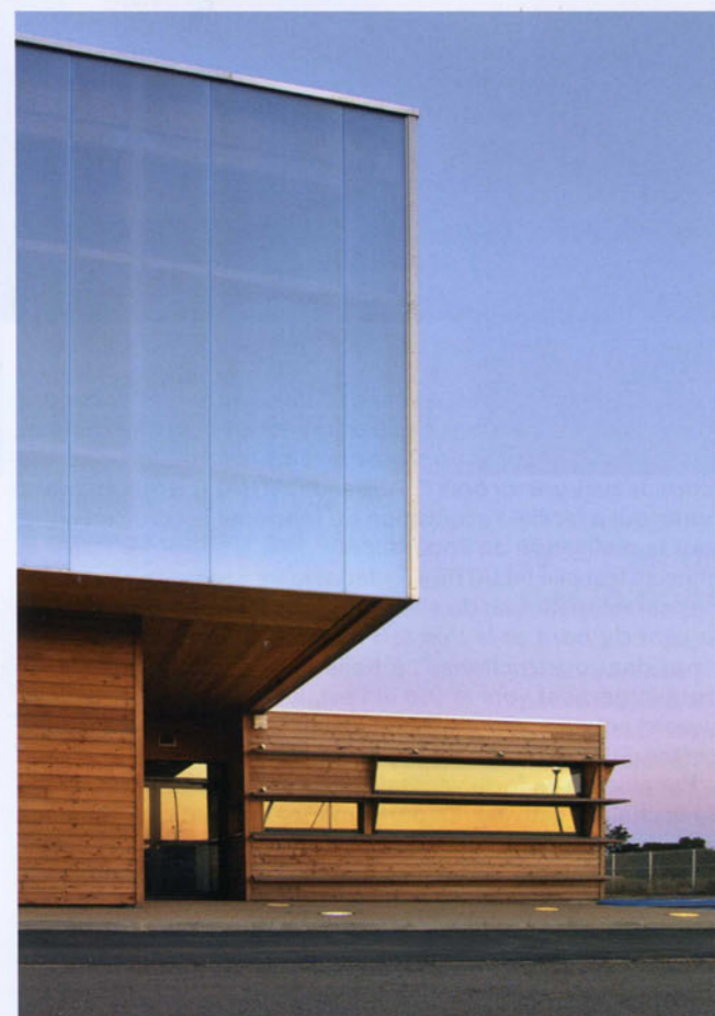
Gymnase de Lansargues dans l'Hérault (Pelus et Meguin architectes)
