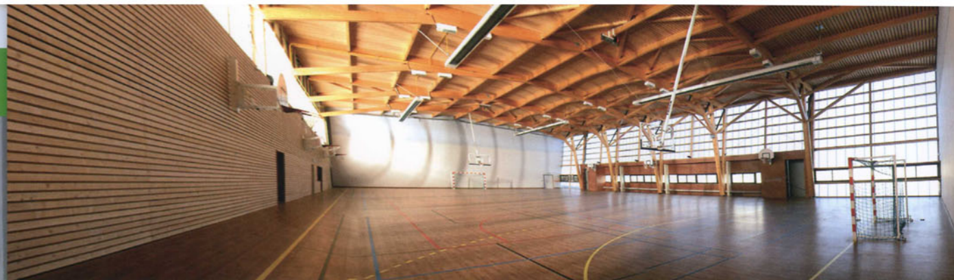
Gymnase de Lansargues dans l'Hérault (Pelus et Meguin architectes)
