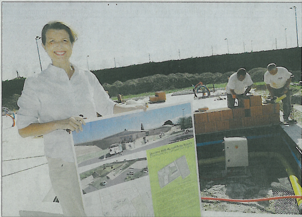
► Devant le chantier en cours, la maire Marlène Thibaud présente le projet de crèche aux méthodes de construction innovantes, qui a valu une Mireille d'or à sa commune.
