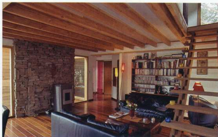
Sur un magnifique plancher en Merbeau traité à la manière pont de bateau avec des joints de couleur crème s'installe un escalier minimaliste réalisé à partir des chutes d'Ipé récupérées de la terrasse. Entre deux parois vitrées, un mur en pierre assure de l'inertie thermique pour absorber et restituer la chaleur issue du poêle.
